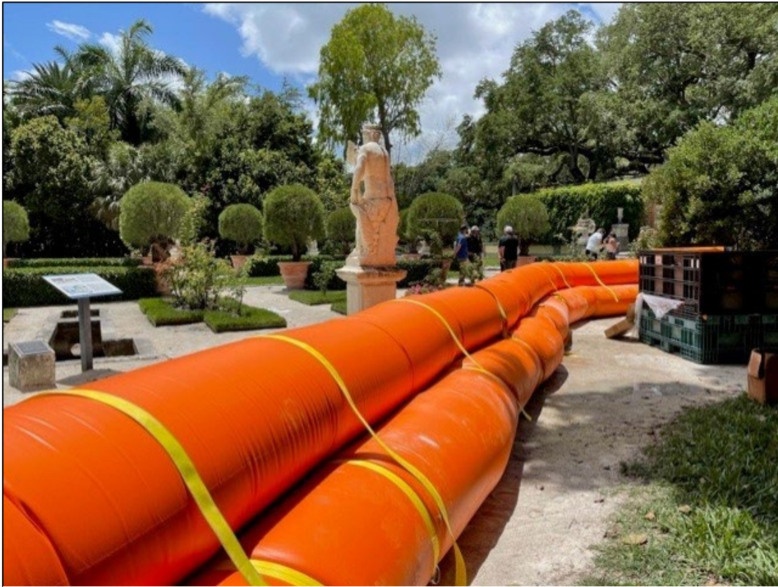
Despliegue del Tiger Dam en los jardines de Vizcaya. Cortesía de Vizcaya Museum & Gardens, Miami, FL.
